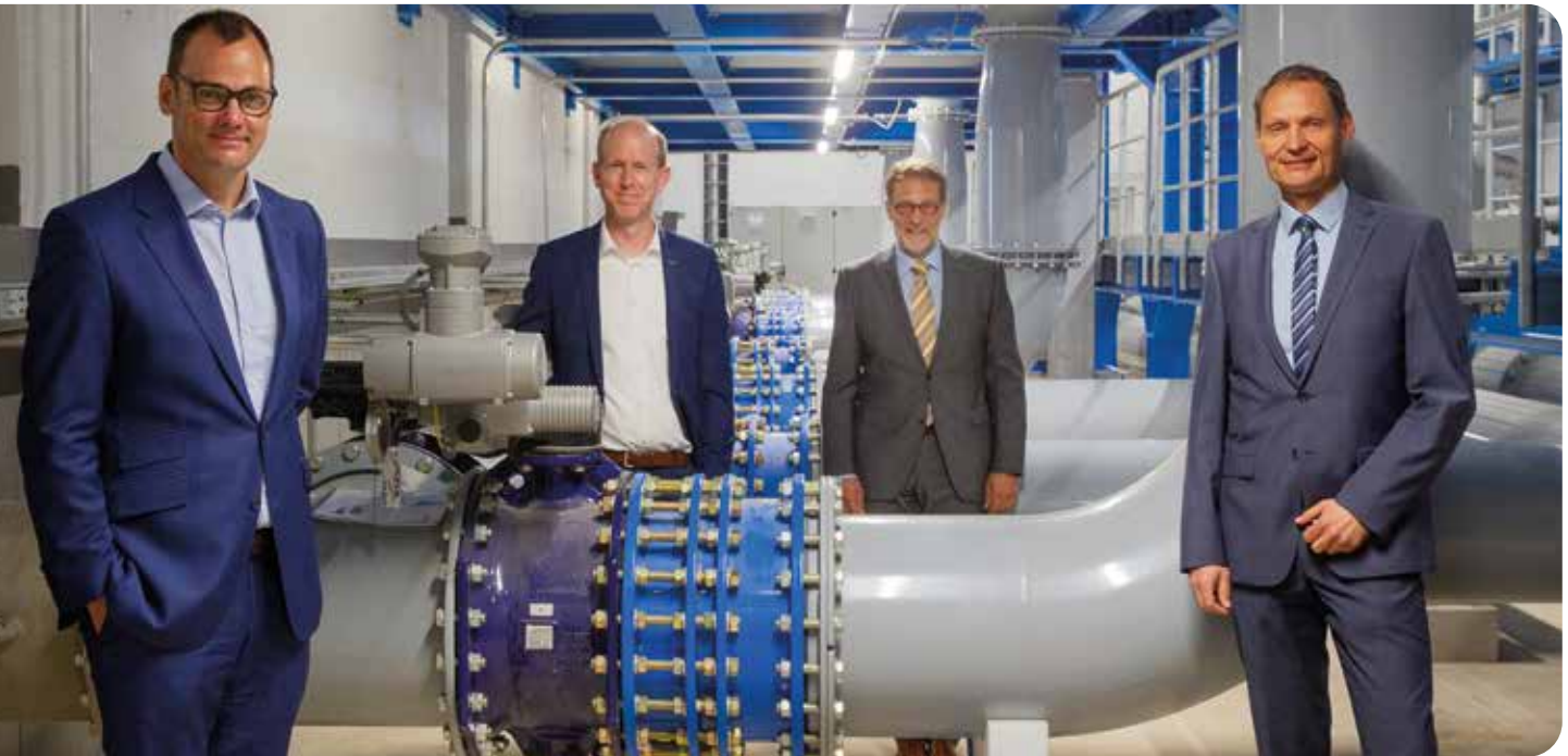
(von links): Henning Deters und Dr. Dirk Waider (Vorstand GELSENWASSER) und Dr. Bernhard Klocke und Bernd Heinz (Geschäftsführung WWW) bei der Inbetriebnahme der „Weitergehenden Aufbereitungsanlage“ im Wasserwerk Westhofen.
