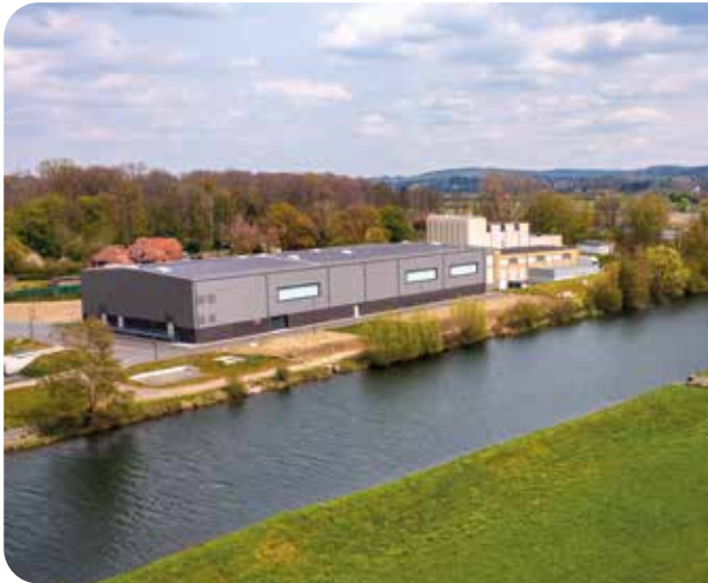
WESTHOFEN (Inbetriebnahme WAA 05/2021)
