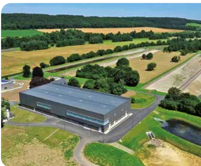
ECHTHAUSEN (Inbetriebnahme WAA 10/2016)
